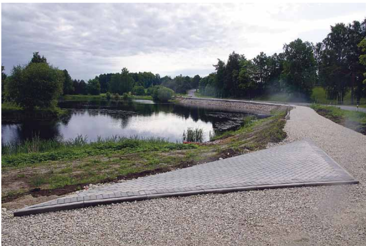
Tsooru kergliiklustee ehitus on lõpujärgus. Kõige problemaatilisem oli Tsooru paisjärve äärne teelõik, kus tuli maapinda tõsta ligikaudu neli meetrit. Pilt on tehtud 6. juunil 2023. Foto: Kalle Nurk
